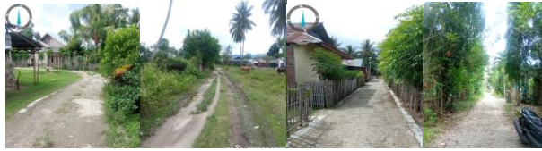
Gambar 2. Kondisi Jalan Lingkungan
