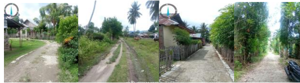
Gambar 2. Kondisi Jalan Lingkungan
